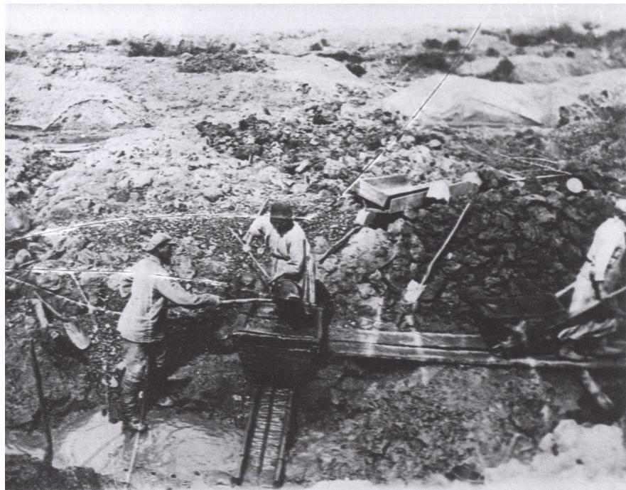
↑ Промывка золотоносной породы на верхнем стане прииска «Пионер» (Якутия, 1935 год).
